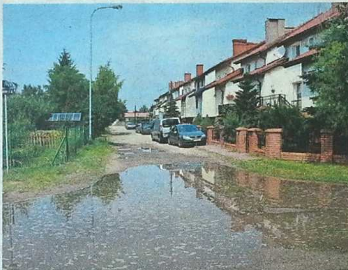
Tak po obfitych opadach wygląda skrzyżowanie ulic Polanickiej i Przemyskiej
